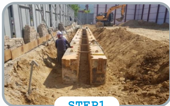
가이드블록 터파기 및 설치
