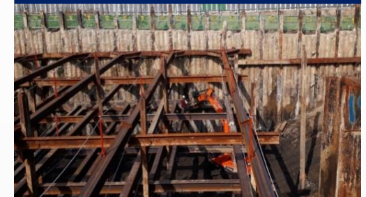
옥동~농소1 도로 개설공사
